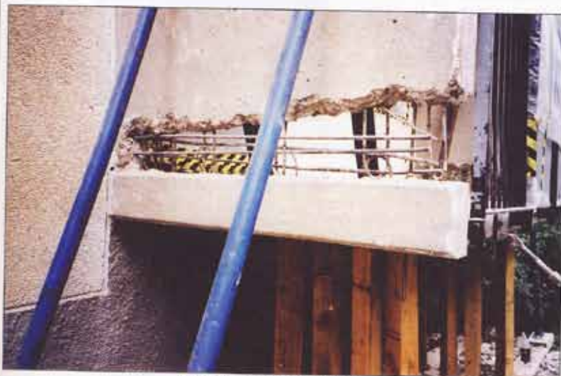
Monterade injekteringsankare.
